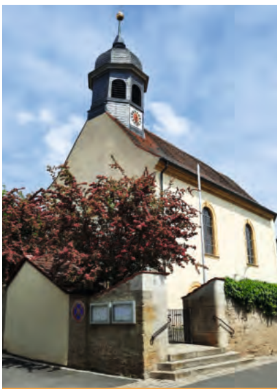
Die Mühlhäuser Kirche von außen. Foto: Patricia Galm
